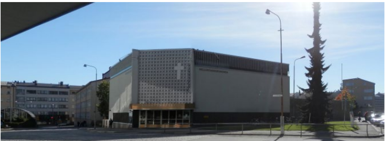
Kuva Siion-temppelin syksyllä 2023 puretusta rakennuksesta Yliopistonkadun puolelta kuvattuna. (9/2014)
